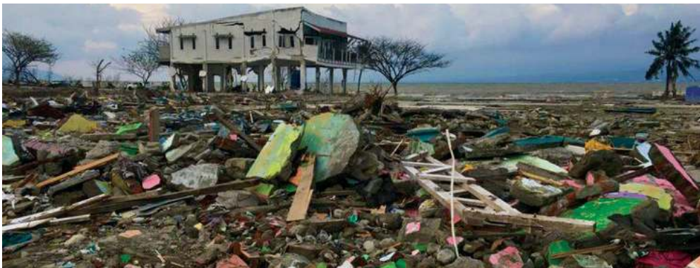
Gambar 4.5. Dampak Tsunami di Palu
