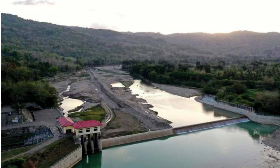
Gambar 4.35. Rehabilitasi Bendungan Benenain NTT Sumber: Kementerian PUPR (2021)
