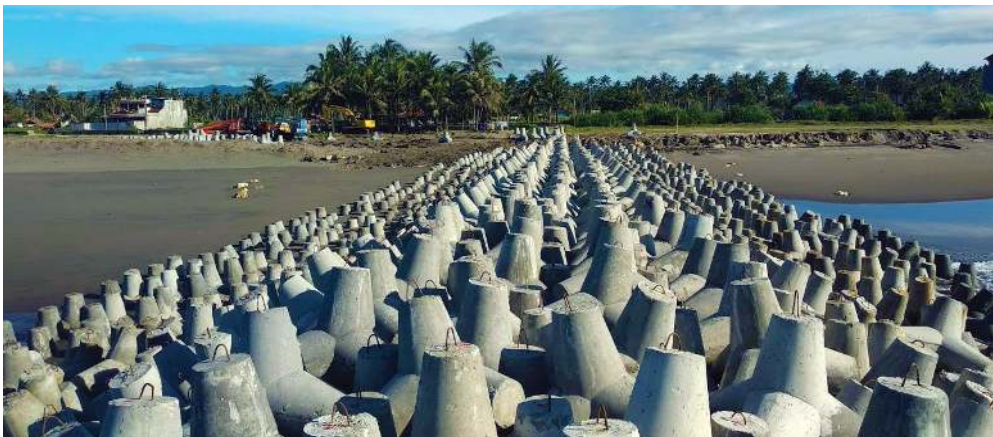
Gambar 4.30. Breakwater di Pangandaran Sumber: kkp.go.id/AJK (2021)
